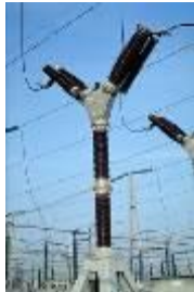
Figure 2. Disjoncteur (©RTE)
