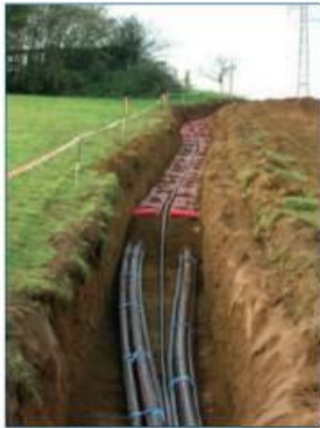
Figure 11 : Exemple de pose en fourreaux
