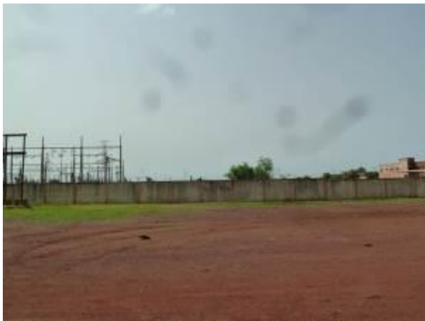
Façade nord du poste de Kodialani avec l'emplacement des nouvelles travées à installer à droite sur la photo.
