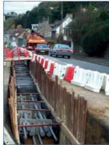
Figure 12 : Exemple de chantier de pose de liaison souterraine
