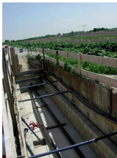
Figure 10 : Exemple d'une chambre de jonction
