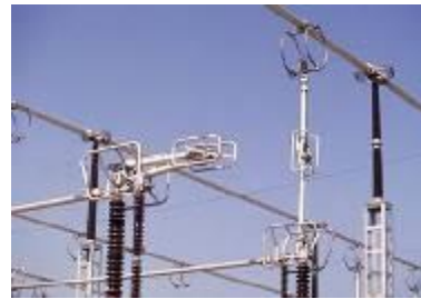
Figure 3. Sectionneur (©RTE)
