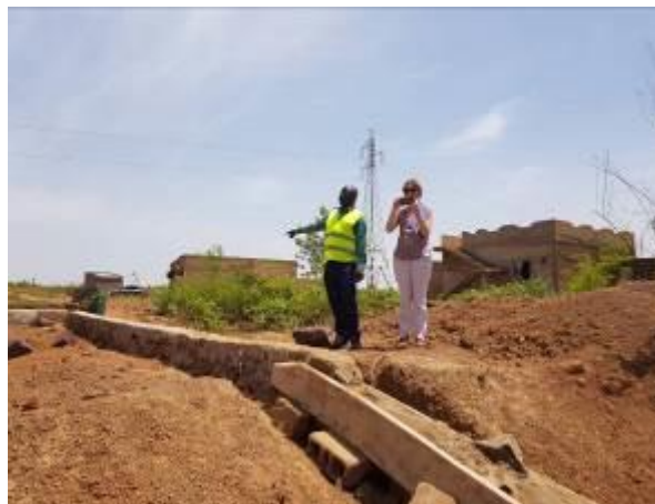
Soubassement sur le site du poste de Dialakorobougou (@X. MONBAILLU)
