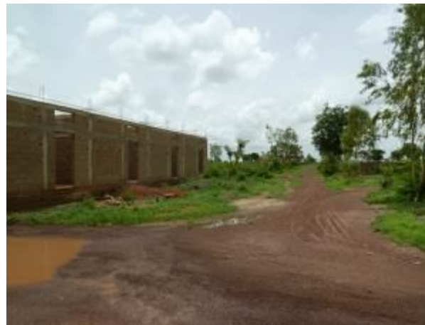
Habitation en construction le long de la piste de Kakabougou. (©X. MONBAILLU)
