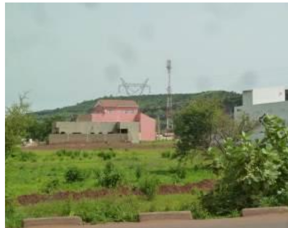
Ligne à 225 kV Kodialani – Manatali passant entre deux maisons au Nord du poste de Kodialani.
